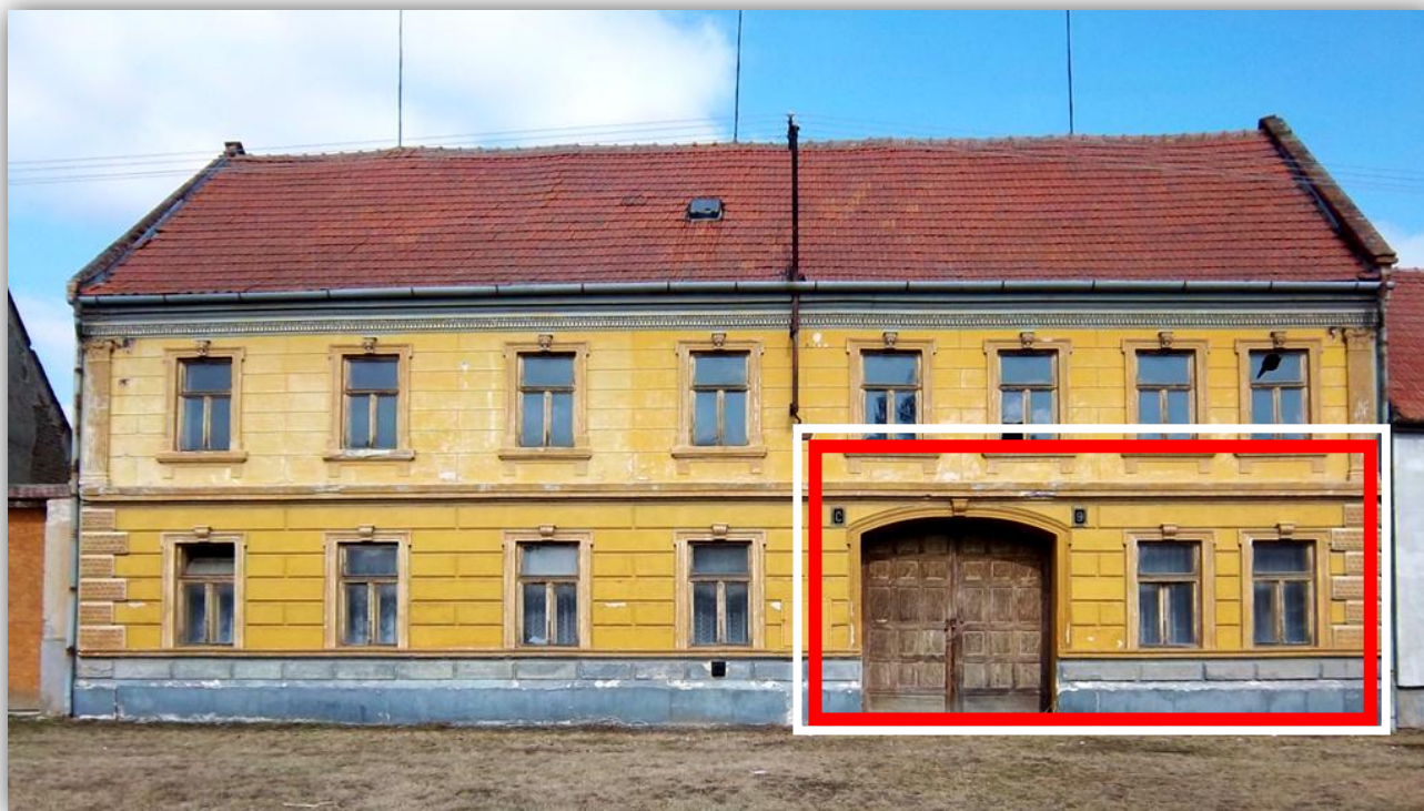
OBJEKT SPOLKU HANÁCI VE SLUŽÍNĚ. V PRAVÉM KŘÍDLE PŘÍZEMÍ SE NACHÁZÍ VSTUPNÍ VESTIBUL A KOMUNITNÍ CENTRUM SLUŽÍN
